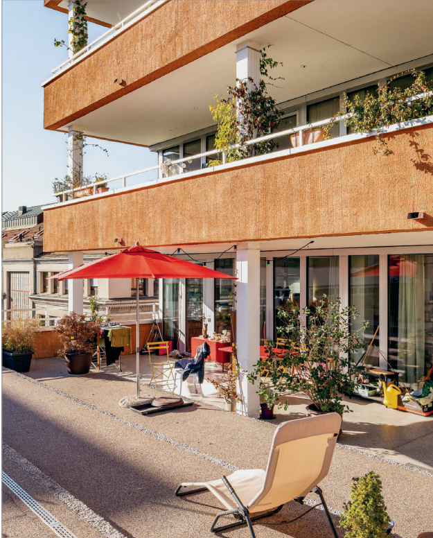
190 Toutes les toitures terrasses sont utilisées pour créer des espaces extérieurs collectifs diversifiés.
