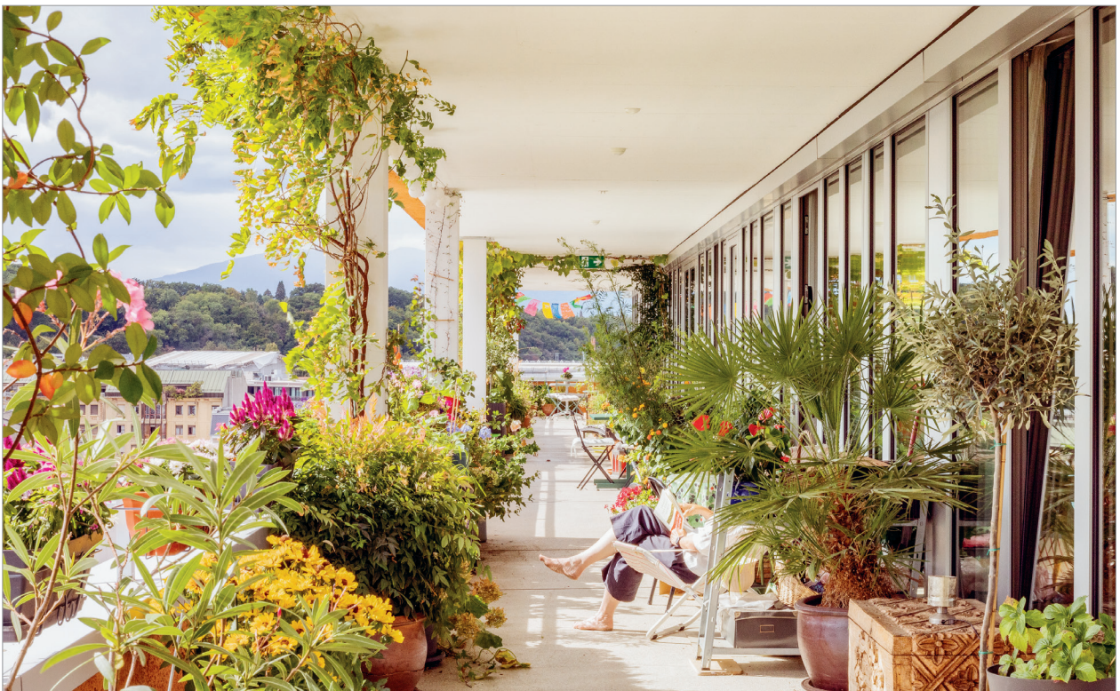
194 Les coursives fonctionnent simultanément comme distribution des appartements et comme balcons.
