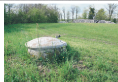
ABB. 182 Die Kugelhaken bieten mit einem Durchmesser von zwei Metern einen Schutzraum für bis zu vier Männer. Auch an ihnen lassen sich die Einflüsse des für die Nachkriegszeit typischen seriellen Bauens und der Vorfabrikation ablesen. Foto undatiert.
