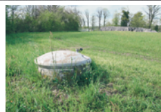
(FIG. 182) Avec leurs deux mètres de diamètre, les bunkers sphériques offrent un abri de protection pouvant contenir jusqu'à quatre hommes. Le témoignage eux aussi de l'influence de la construction en série et de la préfabrication, typiques de l'après-guerre. Photo non datée.
