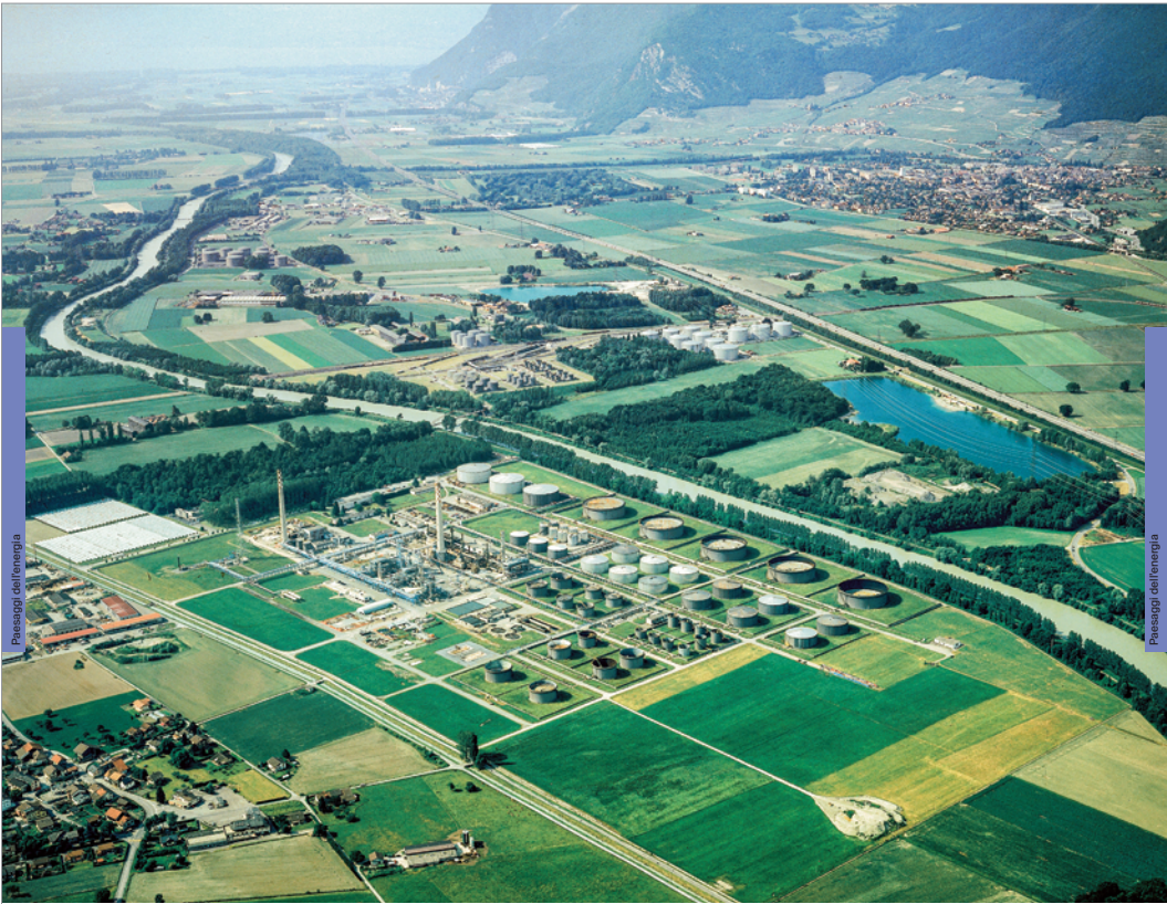
FIG. 145 La raffineria di Colombey, nel Chiablese, è stata operativa dal 1963 al 2015 e dal 2021 è in fase di
