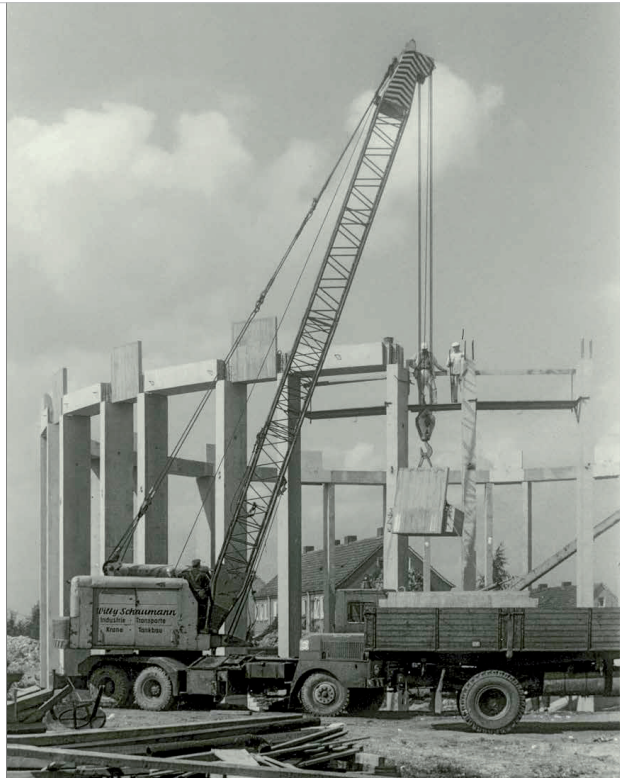
Baustelle, Montage der Betonfertigteile im Bauprogramm / Construction site, assembly of precast concrete elements during the construction process, 1965
