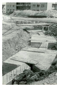
Baustelle, Montage der Betonfertigteile im Bauprogramm/Construction site, assembly of precast concrete elements during the construction process, 1965
