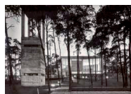
Pfingstbergkirche, Abendbild der Glaskirche/the glass church at dusk Blick auf den Altar./View of the altar
