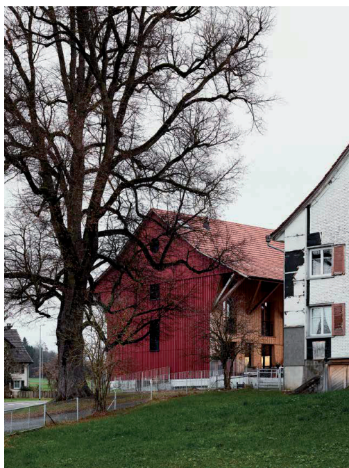
Nachdem die Scheune des historischen Lindenhofs abgebrannt war, entwickelte Lukas Imhof einen Ersatzneubau mit erweiterbaren Wohnungen für fünf Familien. Das neue Haus greift die historische Bautradition auf und interpretiert sie zeitgemäß.
